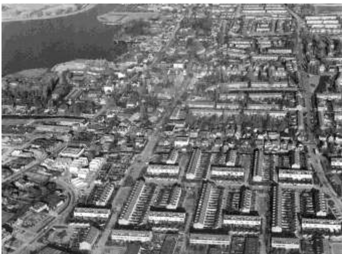
Foto 1985: geheel linksvoor nog net een stukje van Vrij en Blij en dan het Dienstencentrum. Als je de foto goed bekijkt kun je vaststellen dat er inmiddels al erg veel is veranderd: - de sportzaal is nog aanwezig; - er zijn nog bootsteigers bij de Robinson; - het Dorpshuis is nog niet uitgebreid; - de Insp. v.d. Worpsschool staat er nog enz. enz.
