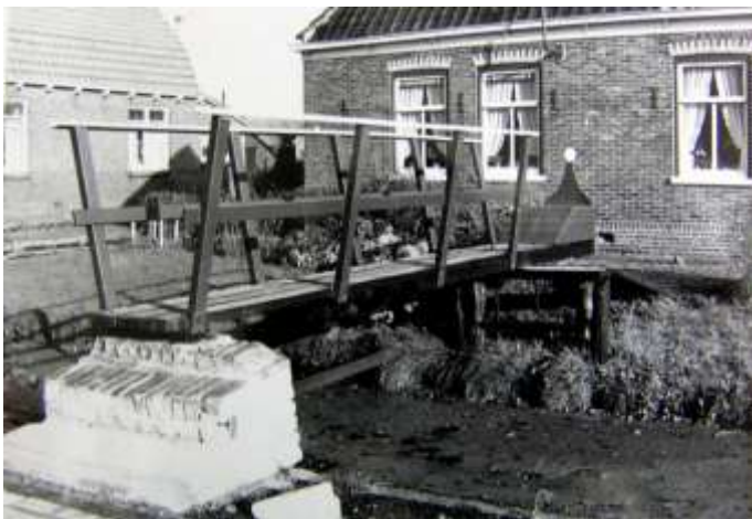
Noordeinde, de panden 41 en 43 met een originele "draai". Deze draaibare bruggetjes waren in de tijd dat bijna alle vervoer over water ging bij zeer veel woningen aan de wegsloot te vinden.
