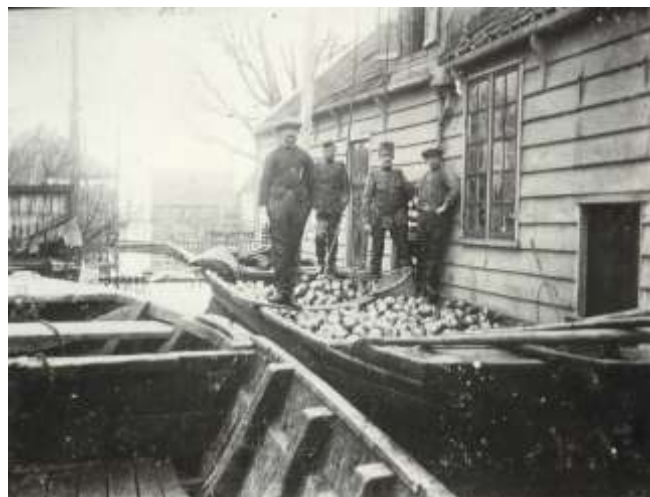
Men is bezig een kaaspakhuis te ontruimen. Op de achtergrond is vaag nog een stukje van de Dorpsstraat te zien.
