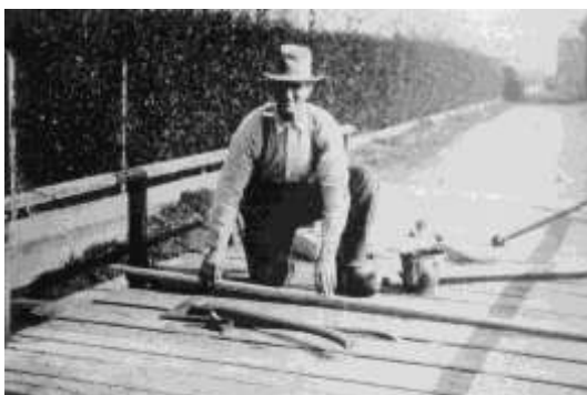
Foto plm 1938: hier is timmerman Hein Hartog van Dorpsstr 11 bezig met de reparatie van een brug.
