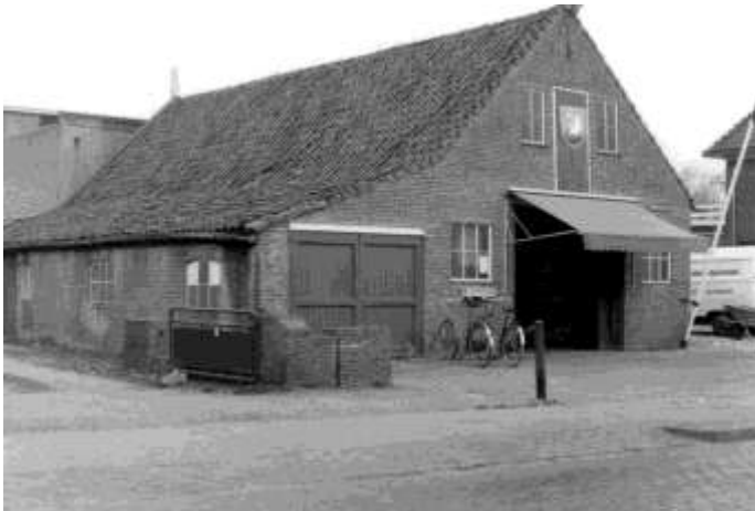
Dit oude pakhuis stond in de Dorpsstraat op het terrein van Adriaan Goede BV.
