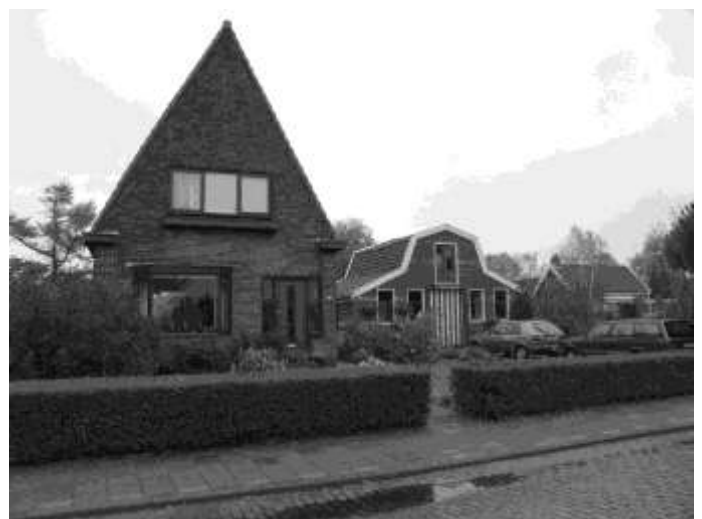
Nadat het pand begin jaren dertig is afgebrand is er dit pand voor in de plaats gekomen. Wel authentiek is het er naast staande als eierpakhuis gebouwde pand. Let ook hier op de opmerkelijke vormgeving, welke je elders in het dorp niet aantreft.
