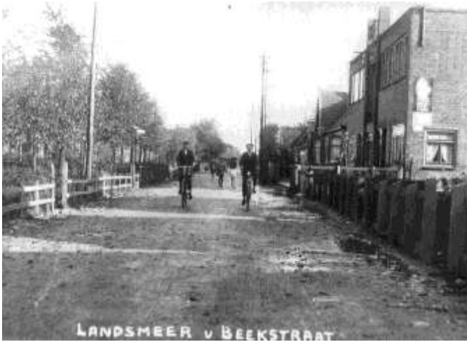
Rechts op deze foto de van oorsprong timmerfabriek, op het moment van de foto echter de electriciteitswinkel van Blankert. Op het bord net boven het raam staat: NSF Radio.
