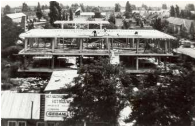
Op deze foto is de bouw van het nieuwe gemeentehuis te zien. Op 30 mei 1969 wordt het in gebruik genomen.
